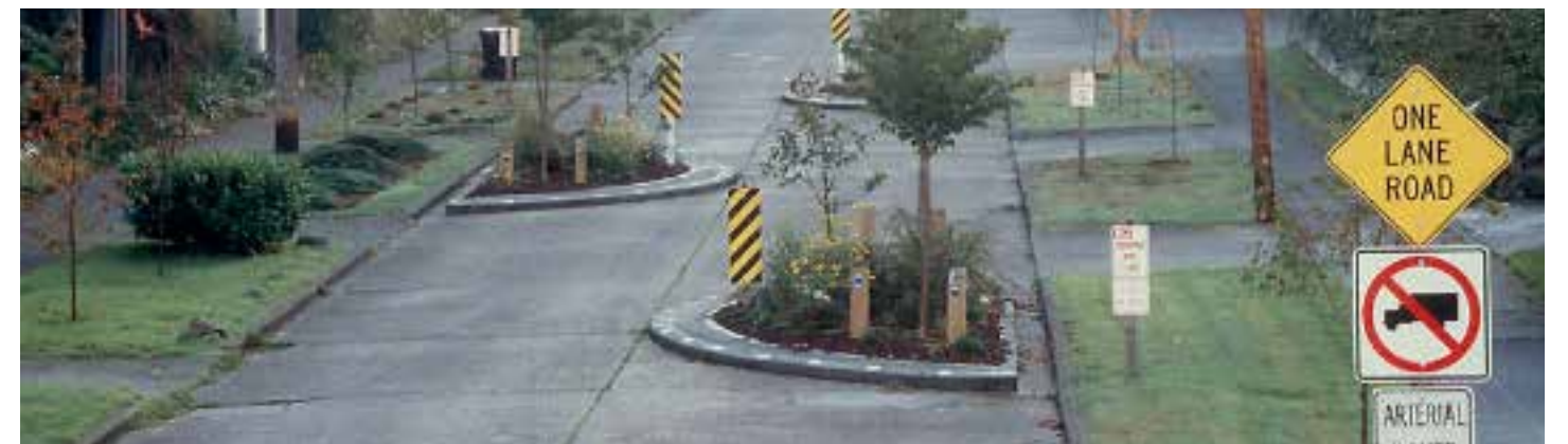
Ilustración 32. Ejemplo de pacificación del tránsito en una calle recta en una zona residencial.
